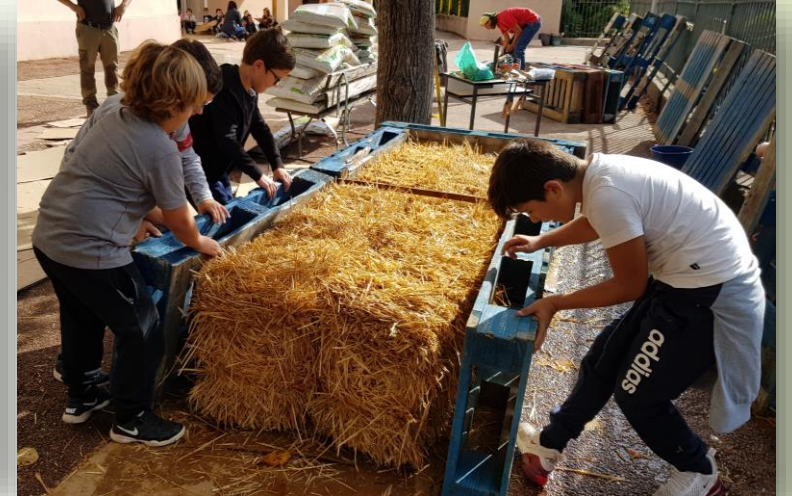
Assemblage: pose des éléments du plan
